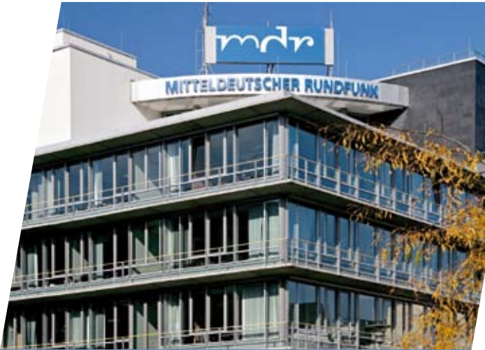
Die Zentrale des MDR Hörfunks in Halle (Saale).
