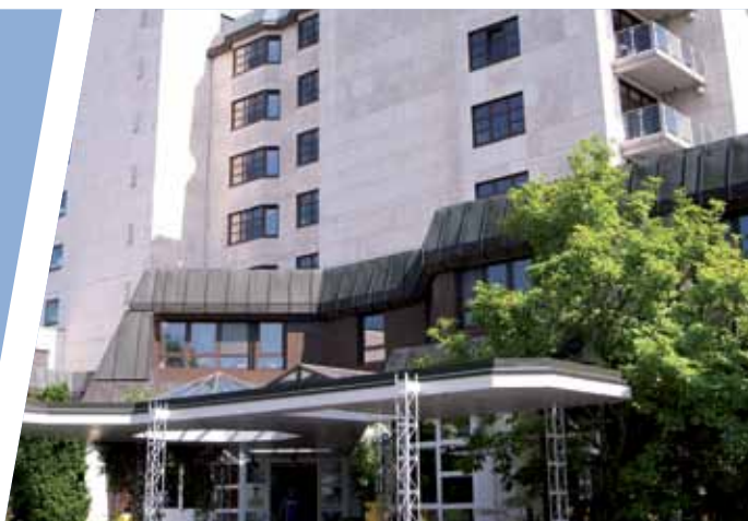
Kliniken Sindelfingen: Neue Heimat des Rechenzentrums und einer der Standorte, die von einer moderneren IT-Infrastruktur profitieren.
